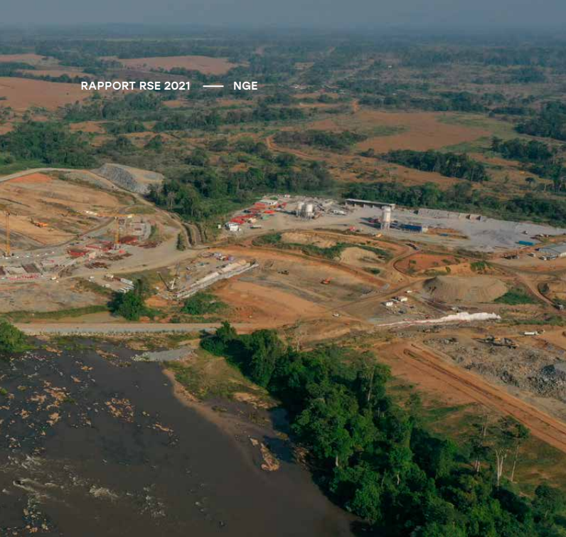
Complexe hydroélectrique sur le fleuve Sanaga à Nachtigal - Cameroun
