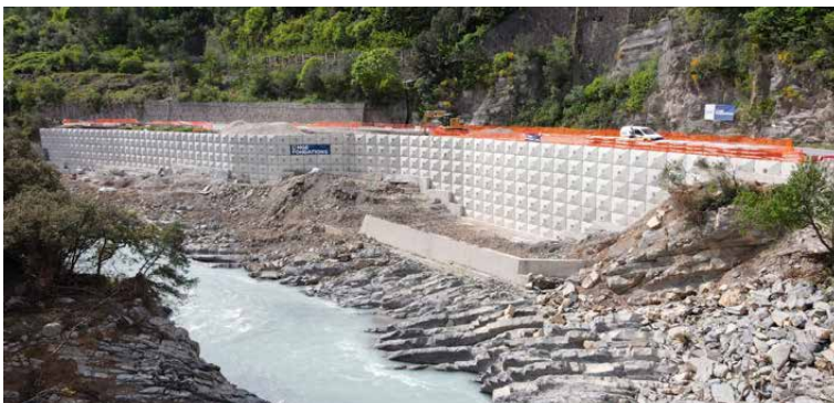
Paroi clouée AD/OC®, Roya
